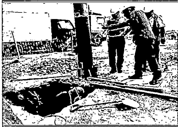
SUPERVISOR DE FONDEPES, EL INSPECTOR DE ELECTROSUR SUPERVISANDO LOS TRABAJOS EN LA OBRA
