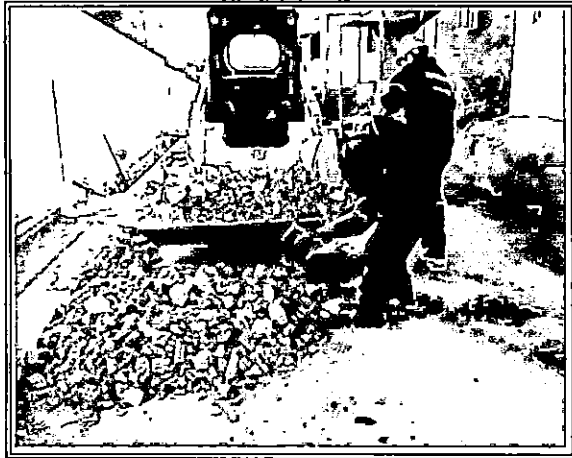
RETIRO DEL DESMONTE (MATERIAL EXCEDENTE) PRODUCTO DE LA LA ROPTURA DE VEREDA Y EXCAVACION
