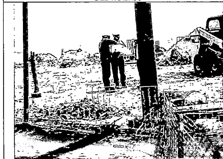
IMAGEN No 09: USO DE MALLAS DE SEGURIDAD EN EL AREA DEL TRABAJO
