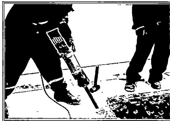
EXCAVACION DE LA SANJA PARA RED SUBTERRANEA (0.60X1.10) CON LA AYUDA DEL MARTILLO ELECTRICO DEMOLEDOR DE CONCRETO
