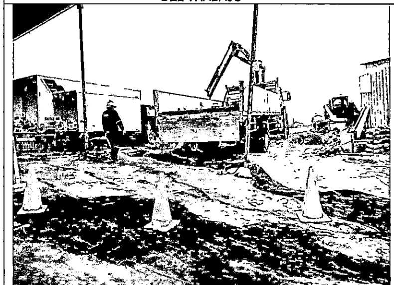
IMAGEN No 06: USO DE CONOS DE SEGURIDAD PARA LA SENALIZACION
